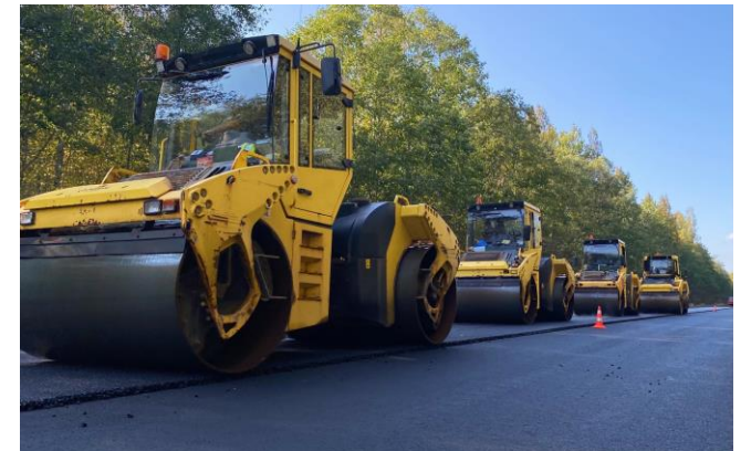
Ремонт дороги Великий Новгород - Луга
