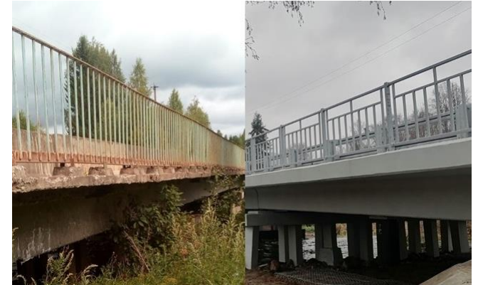
Ремонт моста через р. Кирва
